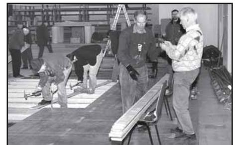
Balken für Balken abgebaut, durchnummeriert, zu Paketen verpackt und gelagert.
